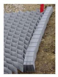
2) Un géotextile Typar® est installé avant de poser les nids d'abeilles DuPont™ GroundGrid®. Le géotextile empêche le matériau de remplissage des cellules (gravier naturel concassé, taille 0/16mm) de s'enfoncer dans le sable fin.
