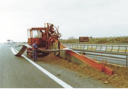
33 pav. Sudėtinio drenažo klojimas kelkraštyje.
